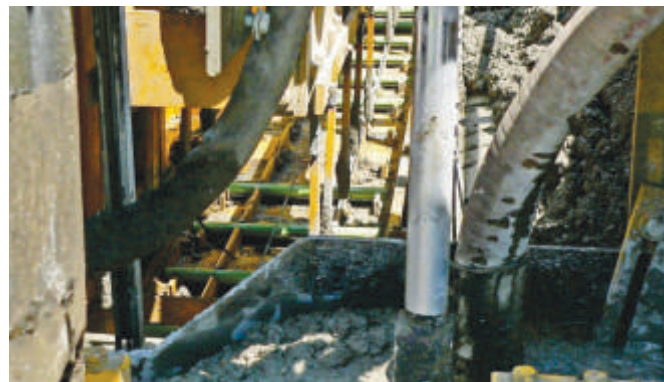
Dowel Bar Inserter
